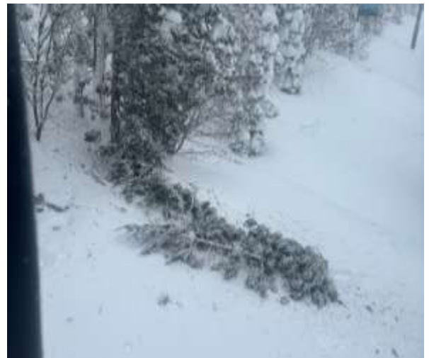
支障木撤去後の状況
