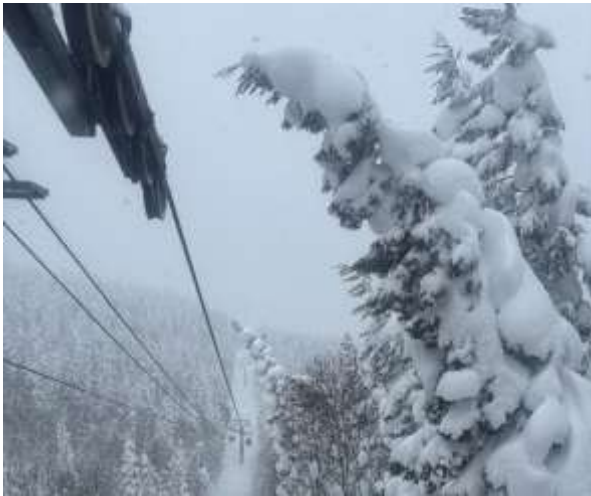
大雪によるゴンドラ線路の支障木
