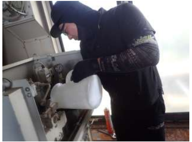
第2ロマンスリフト 油圧緊張装置オイル交換
