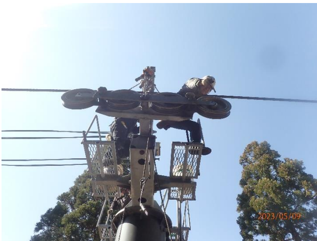
第1ロマンスリフト 支柱索受装置 解体整備
