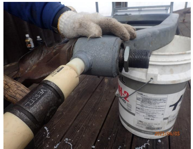
第2ロマンスリフト 搬器振れ止め交換
