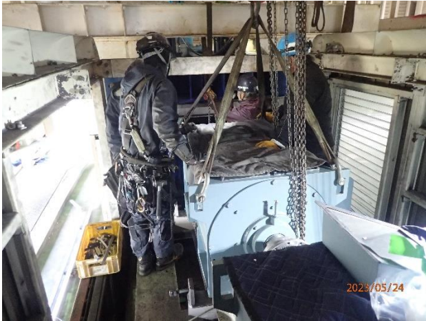
ゴンドラ 原動機オーバーホール工事
