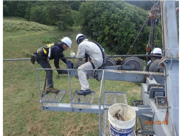
ゴンドラ 支柱索受装置の整備
