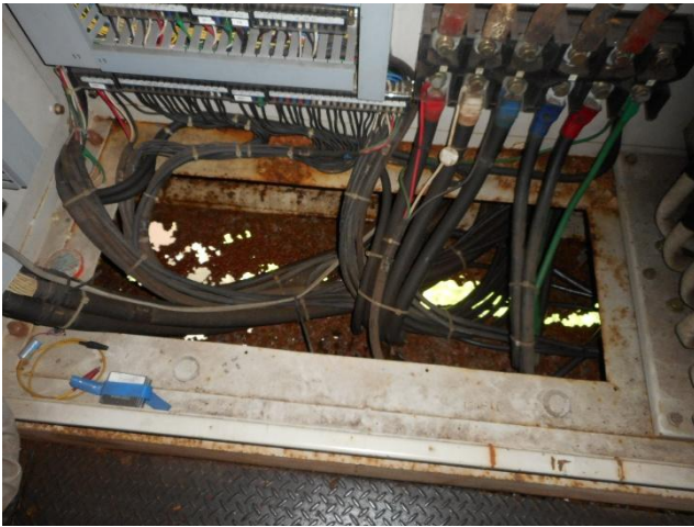
第2ロマンスリフト 機械室床鉄板更新工事
