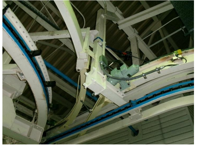
ゴンドラ 搬器入出庫転換機更新
